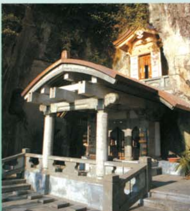
別院不動堂 幼稚園園庭入口を改善しましたので、常にお参り出来るようになりました。
