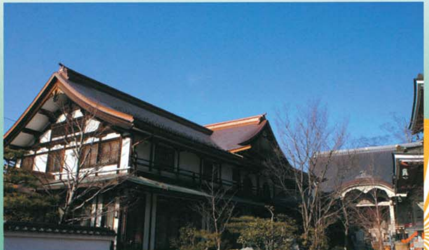
銅板葺き替えにより、建物の耐震性も向上しました
